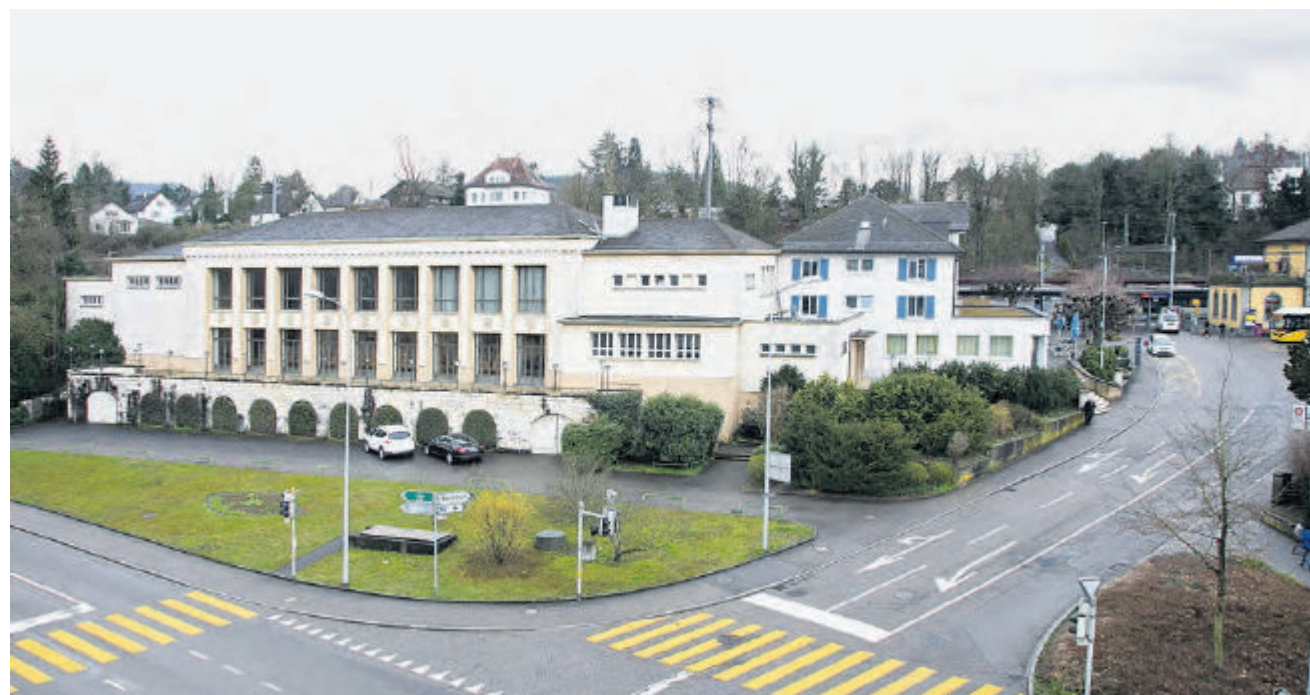
Alles wird anders. Der Bahnhofplatz (rechts) soll umgestaltet, um den Bahnhofsaal (links) soll neu gebaut werden. Foto Nicole Pont
